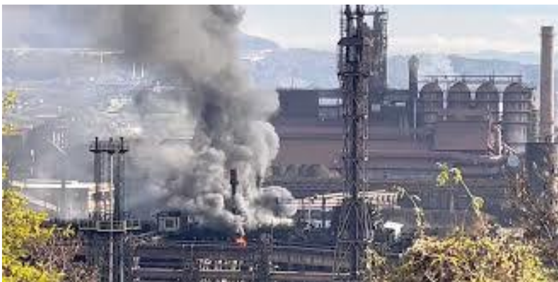
Koksara željezare ArcelorMittal-a u Zenici
